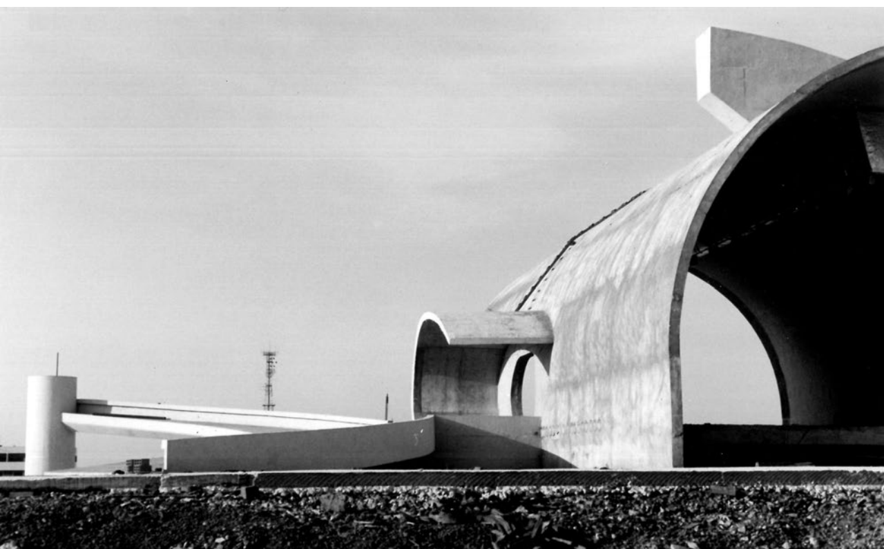
Memorial Coluna Prestes Tocantins, projeto Oscar Niemeyer, em construção, Palmas, 1998.
