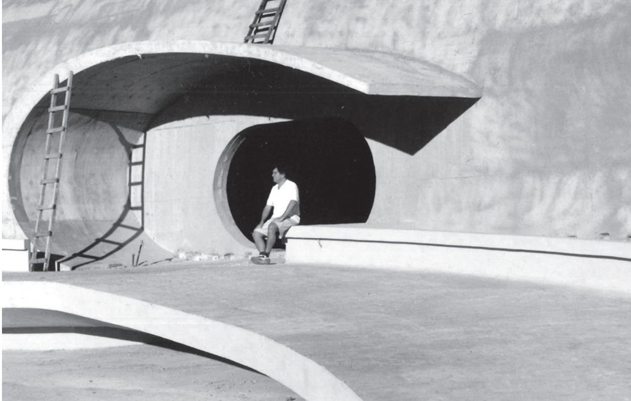
Memorial Coluna Prestes Tocantins, projeto Oscar Niemeyer, em construção, Palmas. Junto a futura entrada, Luiz Carlos Prestes Filho, 1998.
