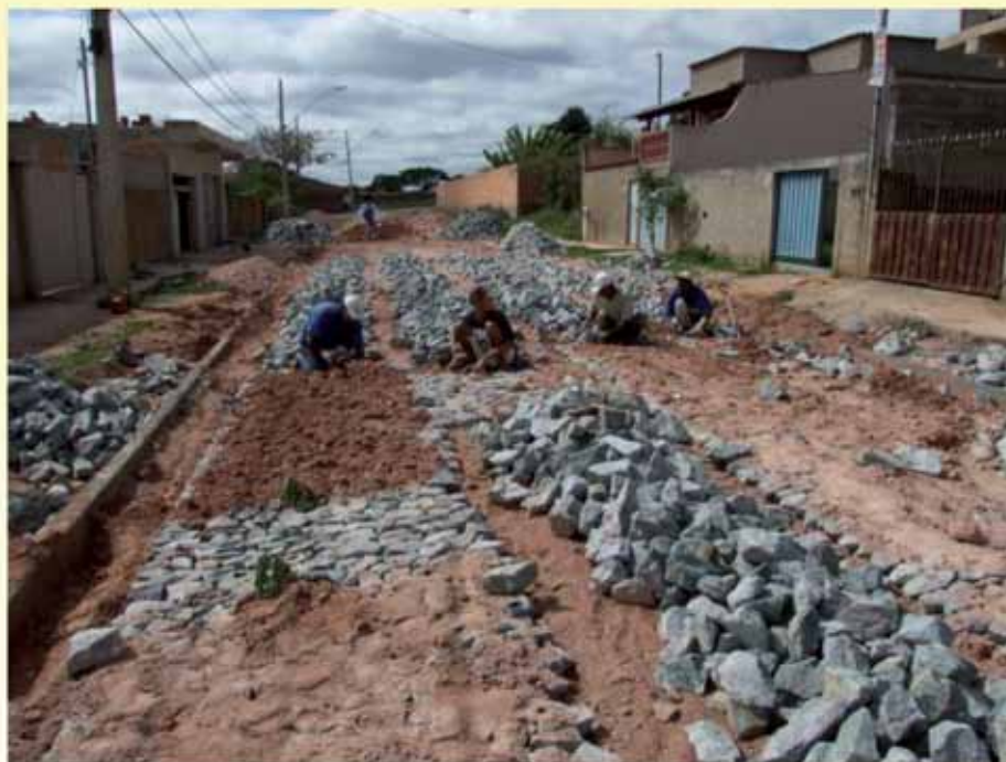
Moradores trabalhando em calçamento de ruas
