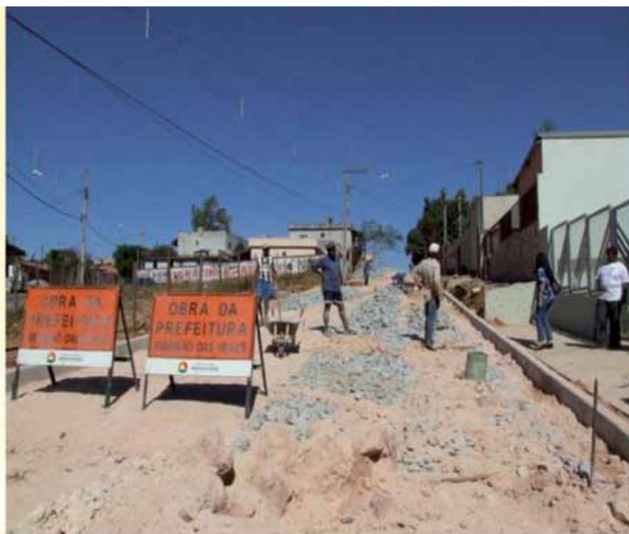
Obras de calçamento – parceria entre Prefeitura e Comunidade
