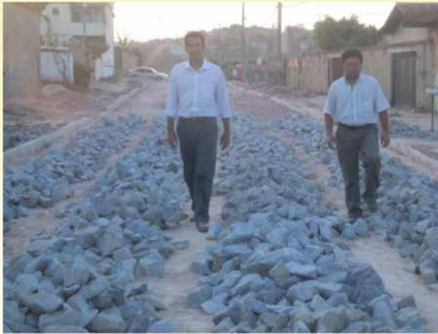
Prefeito e Secretário de Desenvolvimento Urbano em visita às obras de calçamento
